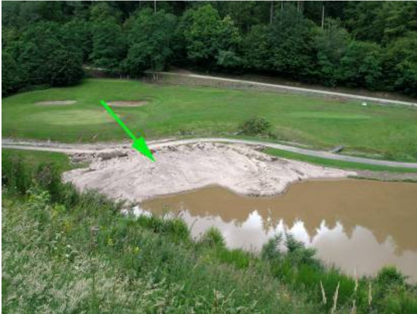
PHOTO 3 : étang (repère 6). La flèche verte pointe le dépôt de matériaux qui a comblé la frange ouest de l'étang. 27 juin 2007.
