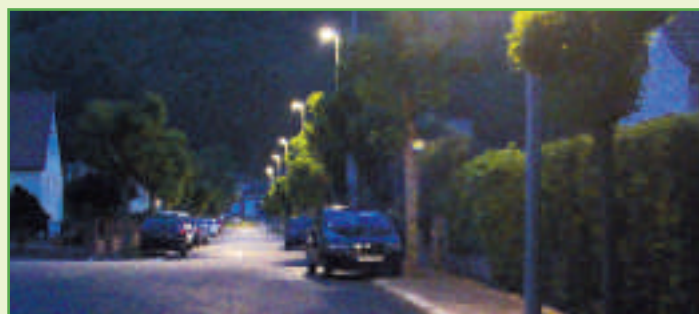
Rue des Acacias, la succession de luminaires a une fonction de guidage et indique une direction.
