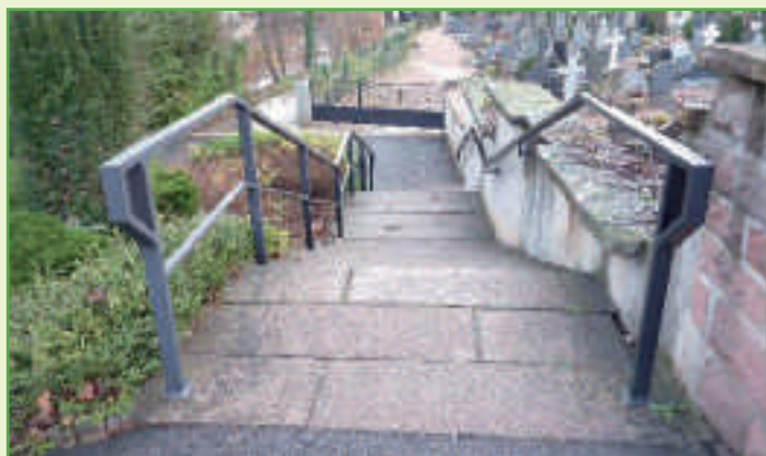
Escalier pour accéder au cimetière
