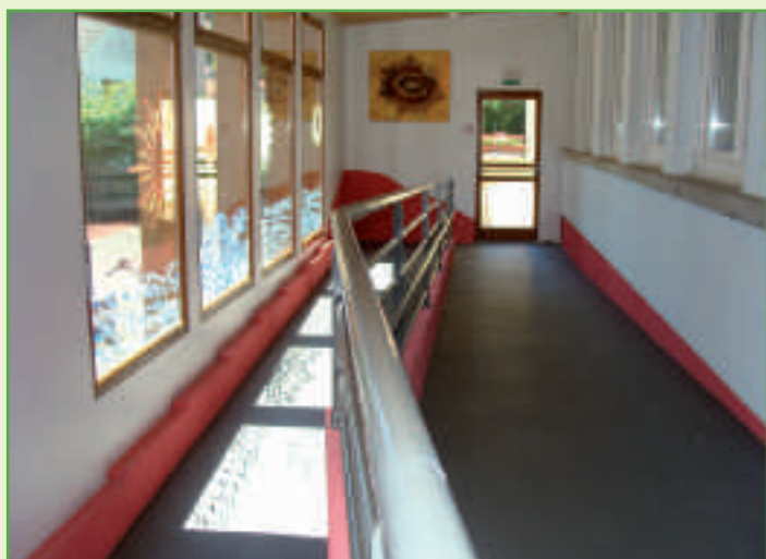
Rampe d'accès du périscolaire
