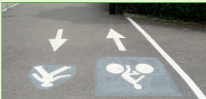
Trottoir élargi partagé par les piétons et les cycles (rue de la Fliéh)
