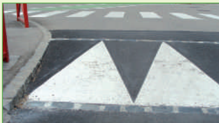
Passage piéton sur une zone surélevée rue des Tilleuls
