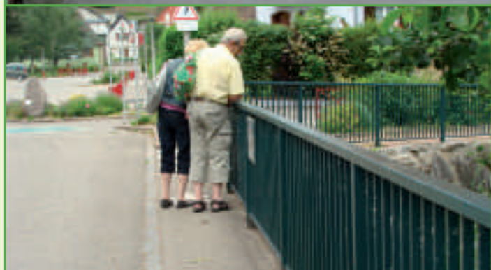
Les trottoirs doivent permettre le croisement confortable et sûr des piétons, ce qui n'est pas encore le cas ici.
