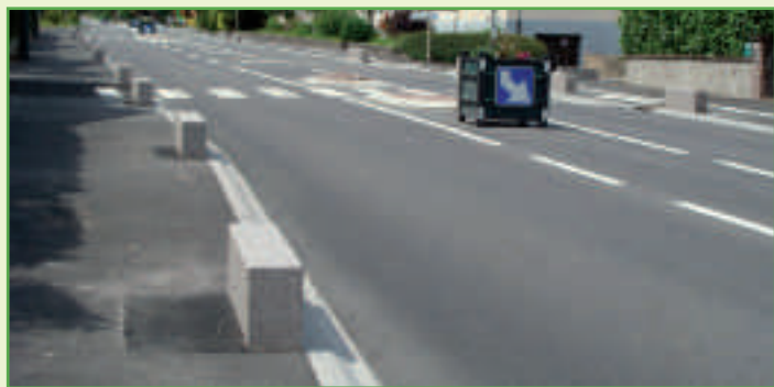
Trottoirs de la RD415
